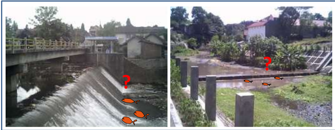
Gambar 12. Desain bendung yang tidak memperhatikan jalur migrasi ikan untuk bereproduksi
